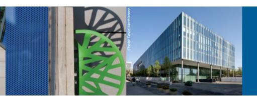
les atriums de façon à réduire les coûts liés à l'éclairage artificiel et au refroidissement du bâtiment. Les coûts énergétiques du bâtiment ont été davantage réduits par l'utilisation d'eau du lac Léman conjointement avec des dispositifs d'échange thermique pour la quasi totalité de ses besoins en matière de refroidissement.
